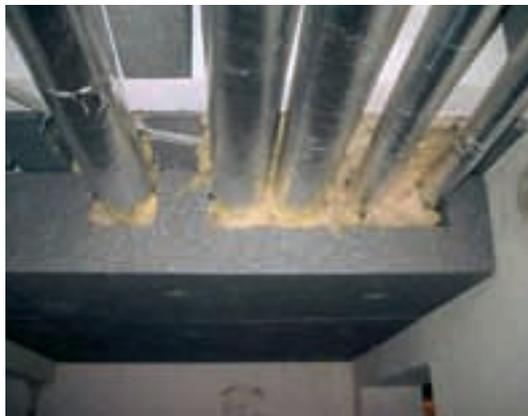
Am Anschlusspunkt Kellerdecke-Außenwand ist eine Wärmebrücke unvermeidlich, da die Kellerdeckendämmung nicht direkt an die Außenwanddämmung angeschlossen werden kann. Die Wärmebrücke lässt sich aber vermindern, indem die Außenwanddämmung ausreichend tief (mindestens etwa 30 cm) unter das Kellerdeckenniveau geführt wird.
