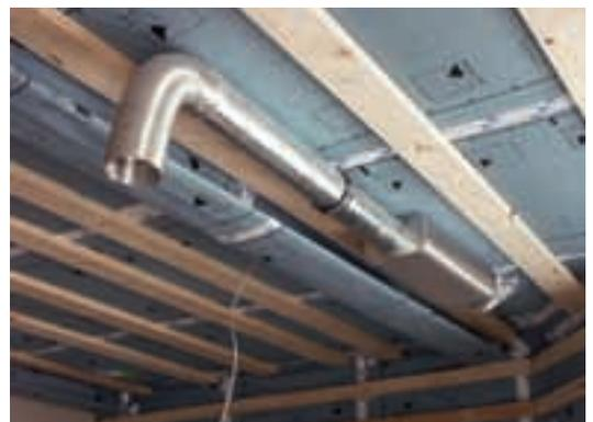
Dachgeschossausbau mit Luftdichtungspappe
