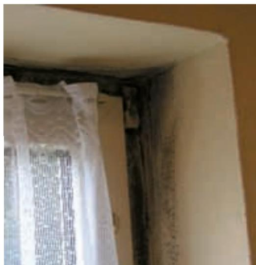
Schimmelpilzbefall in der Fensterlaibung einer ungedämmten Außenwand
