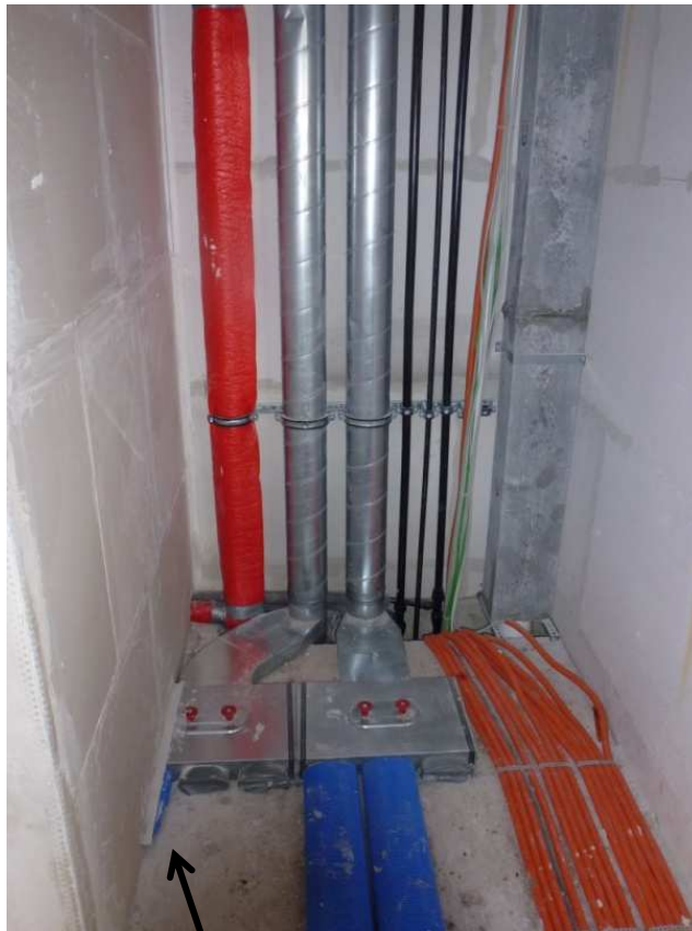
Abluft im EG Küche, Anschluss Gäste WC fehlt noch
