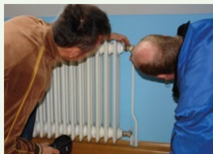
Schritt 3: Abnahme mit Überprüfung der Voreinstellung der Thermostatventile
